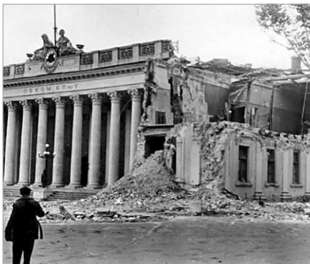
Здание Горсовета, разрушенное оккупантами
